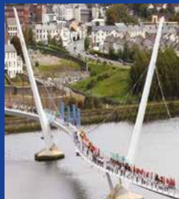
Peace Bridge, Derry-Londonderry
