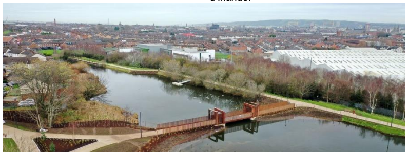
Photo aérienne des travaux achevés à ce jour à Springfield Dam.
