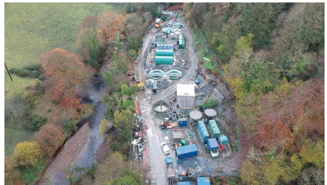
Photo : Station de traitement de l'eau de Donemana
